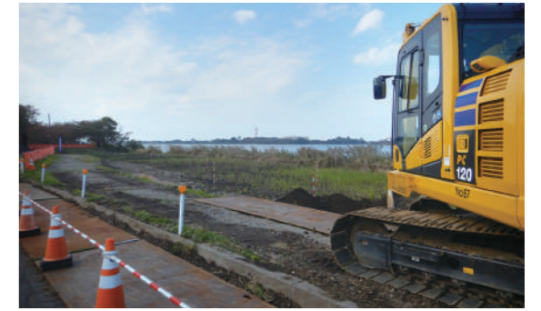
長潟地区湖岸堤工事の状況 (県立スポーツ公園方向を望む, 2024年11月撮影)
