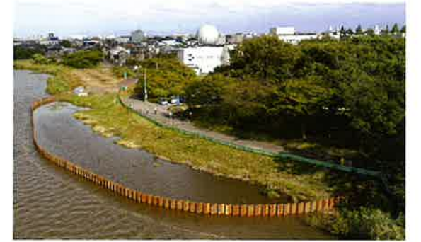
長潟地区湖岸堤工事の状況 (鋼矢板締切完了時 2025年10月撮影)
